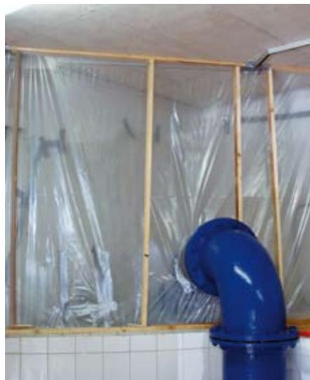
Die Sanierungsarbeiten am Absamer Hochwasserbehälter sind voll im Gange. Die Erneuerung der beiden Wasserbecken kostet rund 300.000 Euro netto. Zu diesem Zweck werden die alten Fliesen entfernt, der Untergrund einer Hochdruckwasserreinigung unterzogen und eine neue, trinkwassertaugliche Zementmörtelauskleidung angebracht. Zusätzlich werden in den beiden Becken die Zu- und Ablaufverrohrung und die
