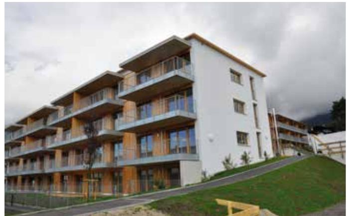
Bis Herbst 2015 wurden im ersten Bauabschnitt acht Reihenhäuser im Eigentum, 23 Mietwohnungen mit einer Tagespflegestätte sowie 18 Eigentumswohnungen samt Tiefgarage errichtet. Die Randhäuser sind als Niedrigenergiehäuser und die Mittelhäuser als Passivhäuser in Massivbauweise ausgeführt.
